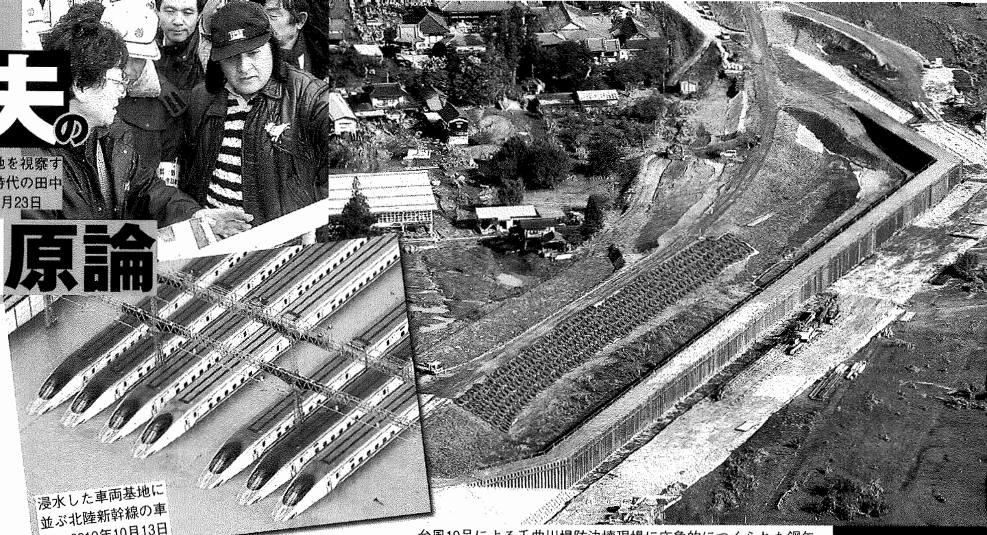
台風19号による千曲川堤防決壊現場に急应的につくられた鋼矢板仮締切堤防=2019年10月30日
